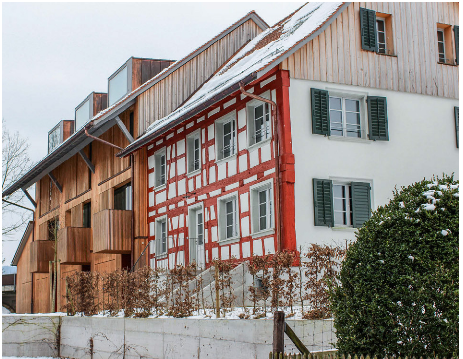
Neu und alt: Die historische Liegenschaft an der Hauptstrasse in Rheinklingen fiel 2008 einem Brand zum Opfer und wurde 2012 wieder aufgebaut.
