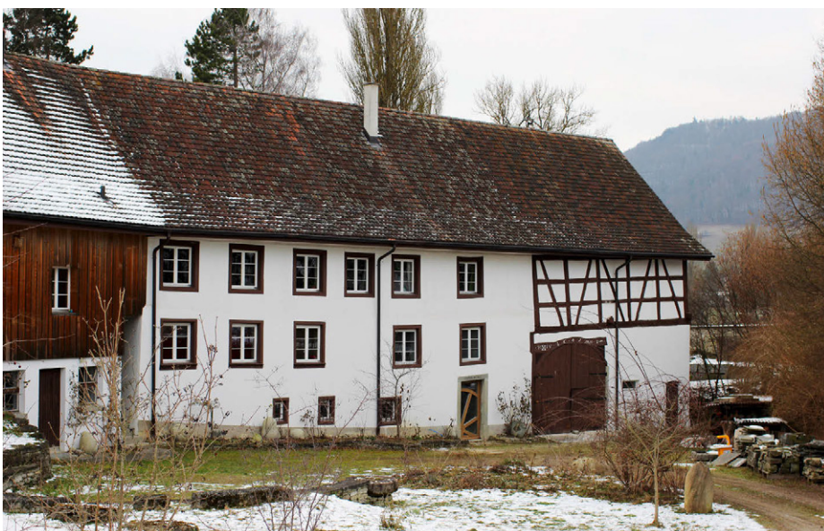
Die untere Mühle von Wagenhausen wurde im Jahr 1315 urkundlich erwähnt. Sie war bis Anfang des 20. Jahrhunderts in Betrieb.
