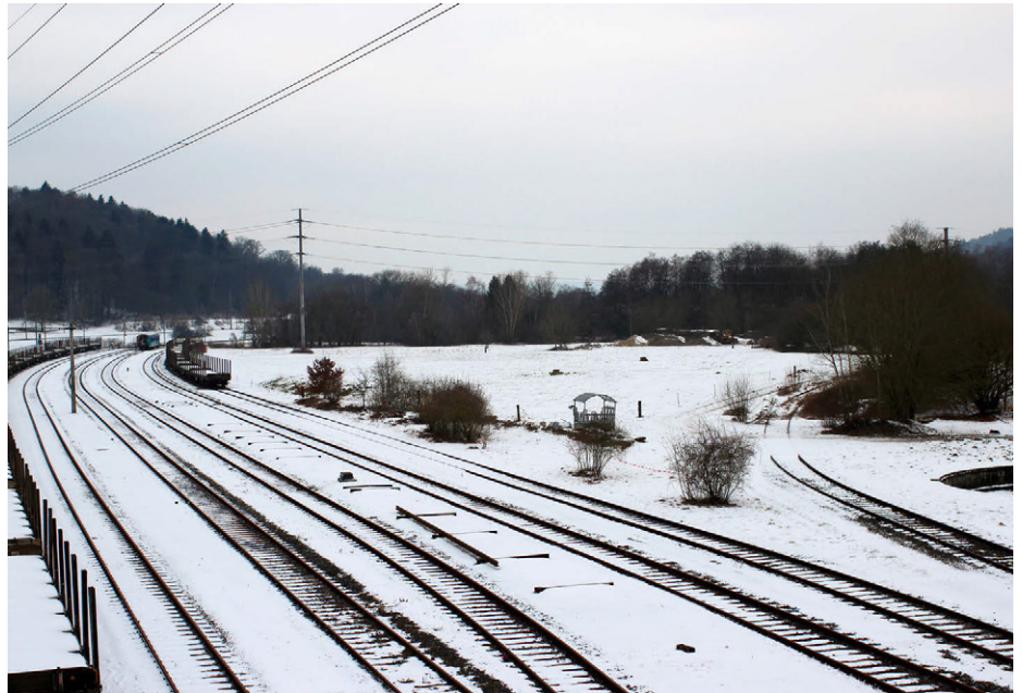
Auf dem SBB-Areal im Ortsteil Etwilen hinter den Gleisen soll die Geothermieanlage zu stehen kommen.
